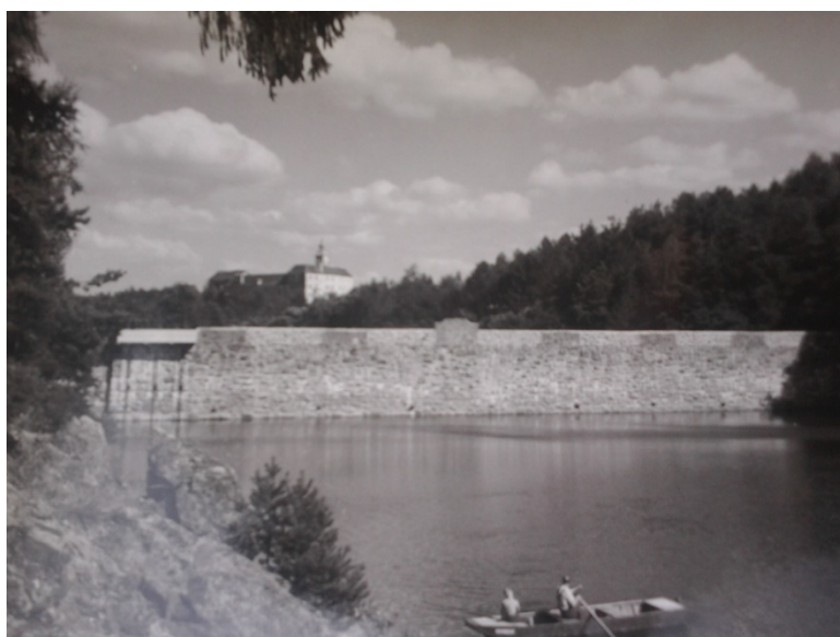
hráz po úpravě v roce 1951
